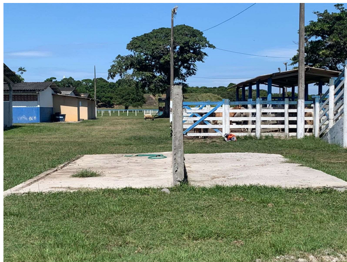
Fotos 15, 16, 17 e 18 – Área de banho de cavalos atual
