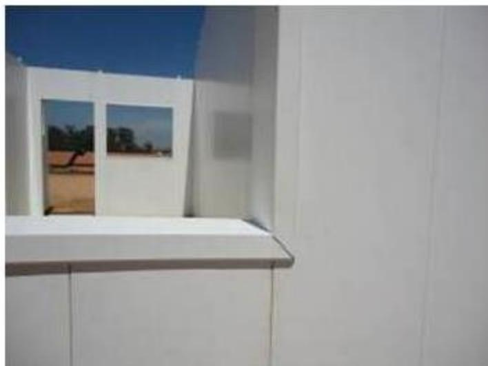
**Figura 15 – Abertura das janelas com acabamentos em PVC**
