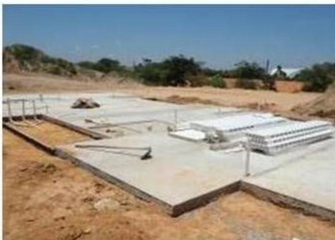
**Figura 8 – Elemento de fundação com planicidade adequada**
