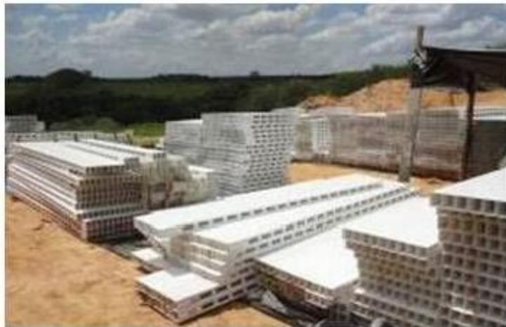
**Figura 10 – Painéis de PVC pré-moldados na fábrica**
