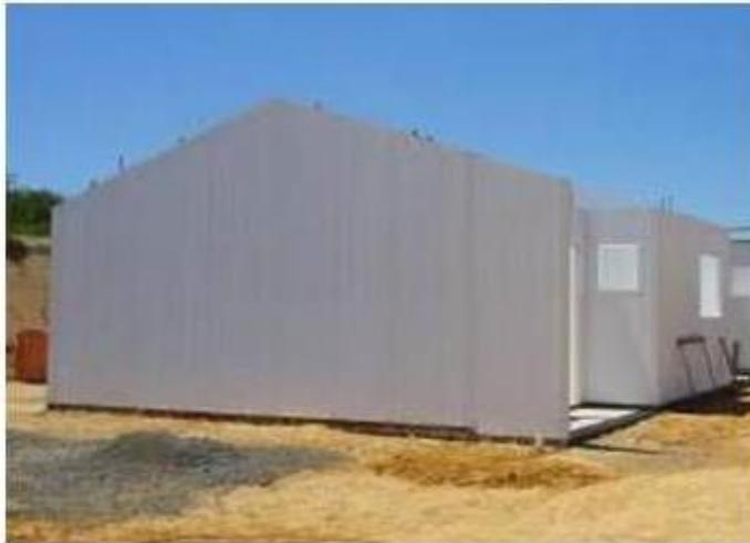
**Figura 14 – Painéis de PVC concretados**
