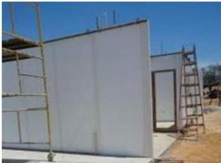
**Figura 11 – Painéis de PVC posicionados e escorados**
