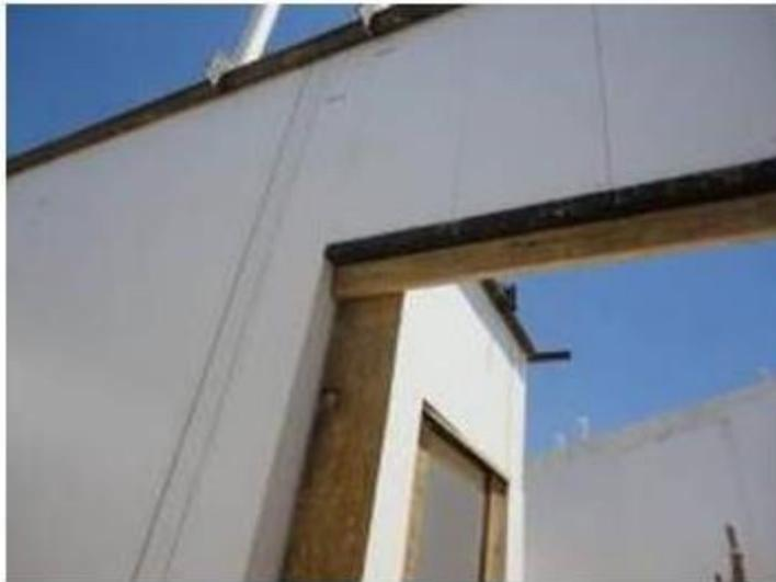
**Figura 13 – Escoramento de aberturas de portas para concretagem**
