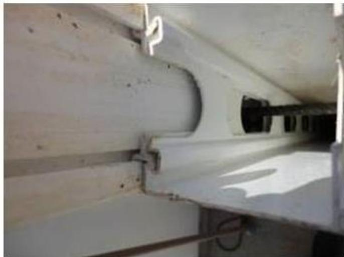
**Figura 12 – Ferragem posicionada na região da contra-verga**
